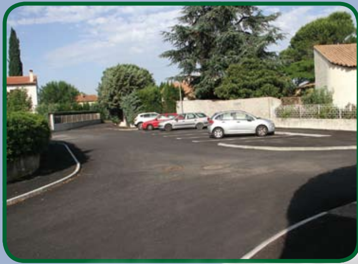
Réfection rue des Rosiers
