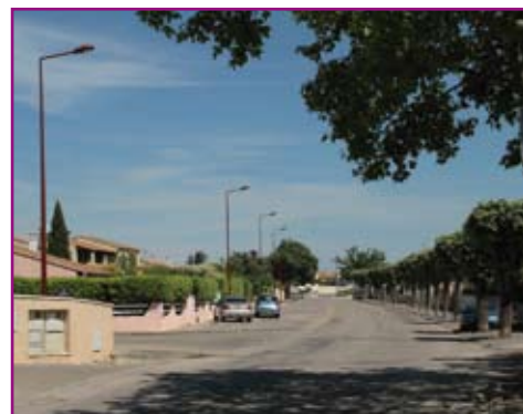
Éclairage public avenue Georges Dayan
